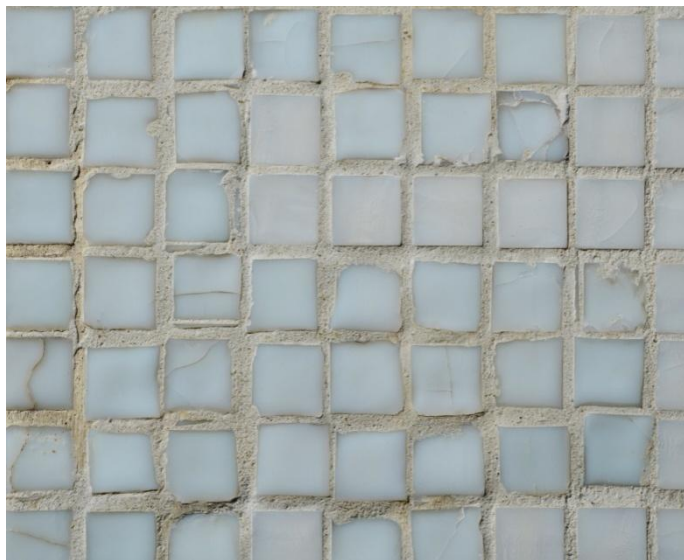
Obr. 6: Detail doplnění chybějících bílých kostek replikami.
