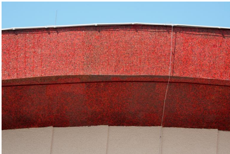
Obr. 9: Pohled na korunní římsu sálu kina po doplnění chybějícího obkladu replikou.
